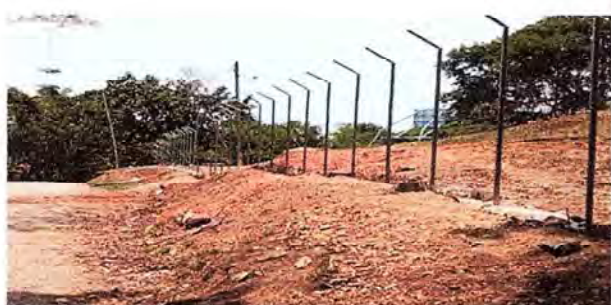
Foto 5: Colocación de tubos galvanizados parte de enfrente
