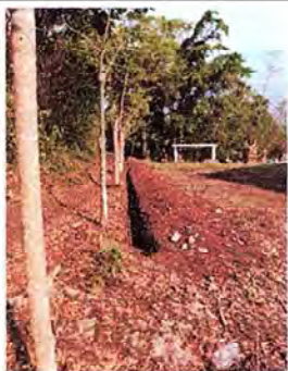
Foto 1: Zanjeado parte lateral derecho
