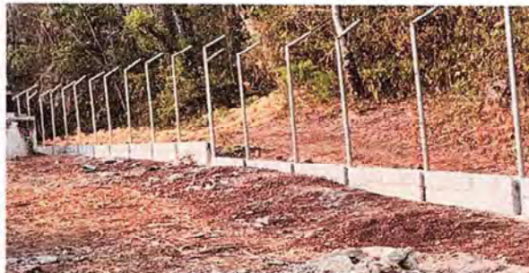
Foto 6: Colocacion de tubos parte de atras
